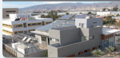
Infraestructuras de investigación incluidas en el proyecto SFERA II | SFERA II project research Infrastructures
